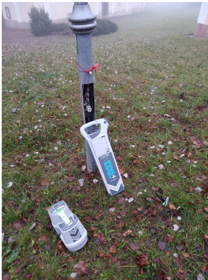
Obr. 3 Určování průběhu kabelového vedení
