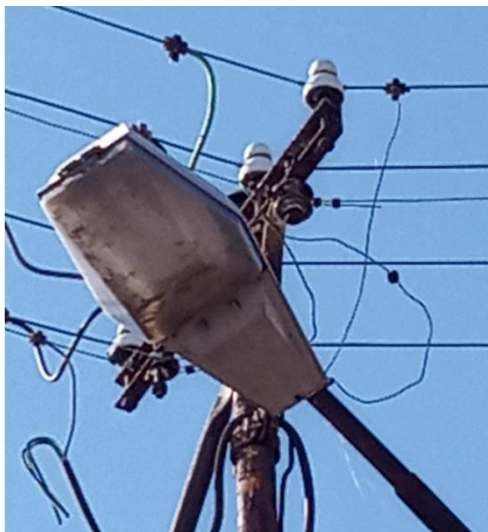
Obr. 28 Nečistoty v difuzoru
